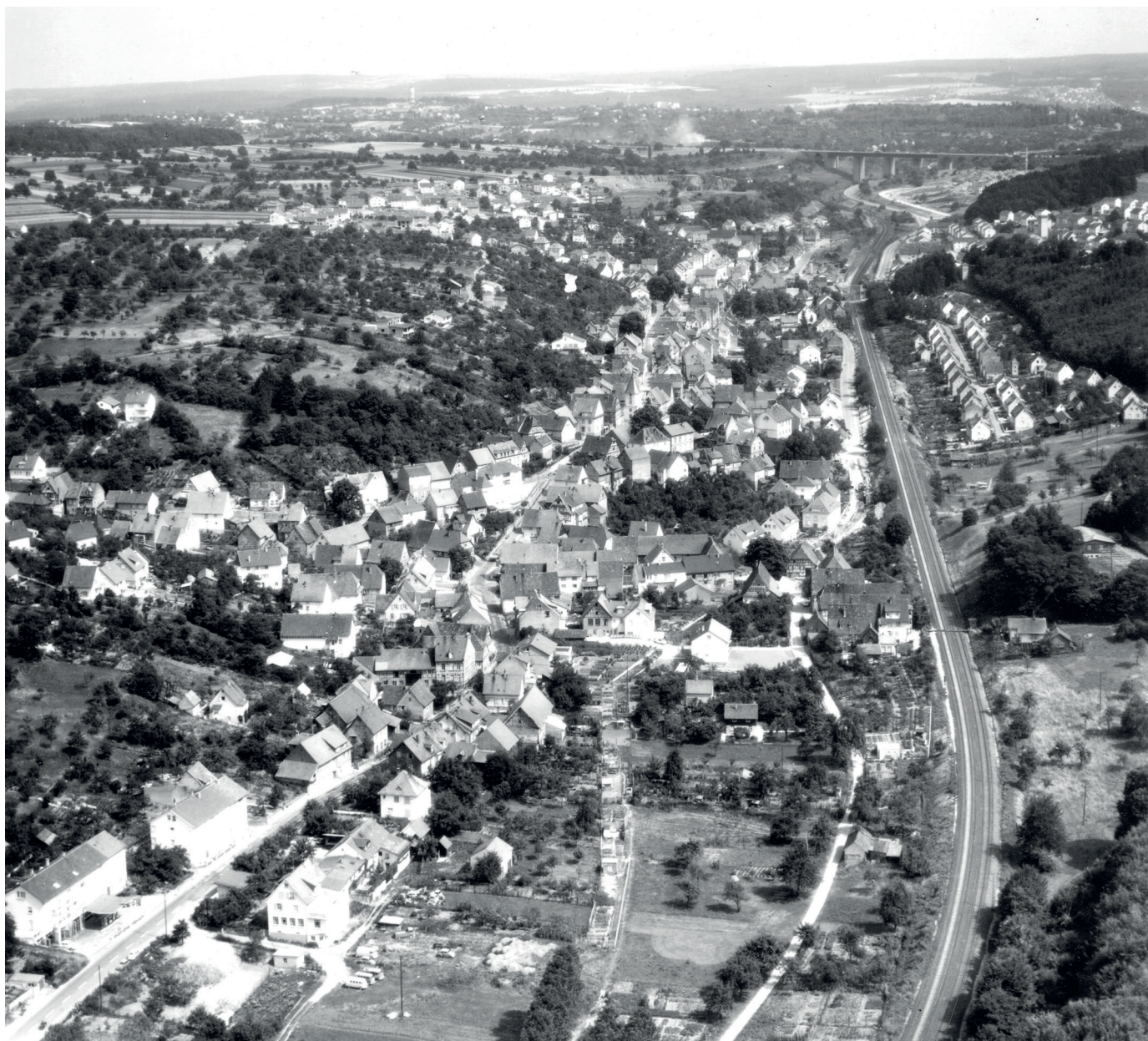
Ispringen um 1964 von Westen aus gesehen. Im Vordergrund sind die Abschlussarbeiten der Verdolung des Kämpfelbaches zu erkennen. Rechts die neu entstandene Siedlung südlich der Bahnlinie.
