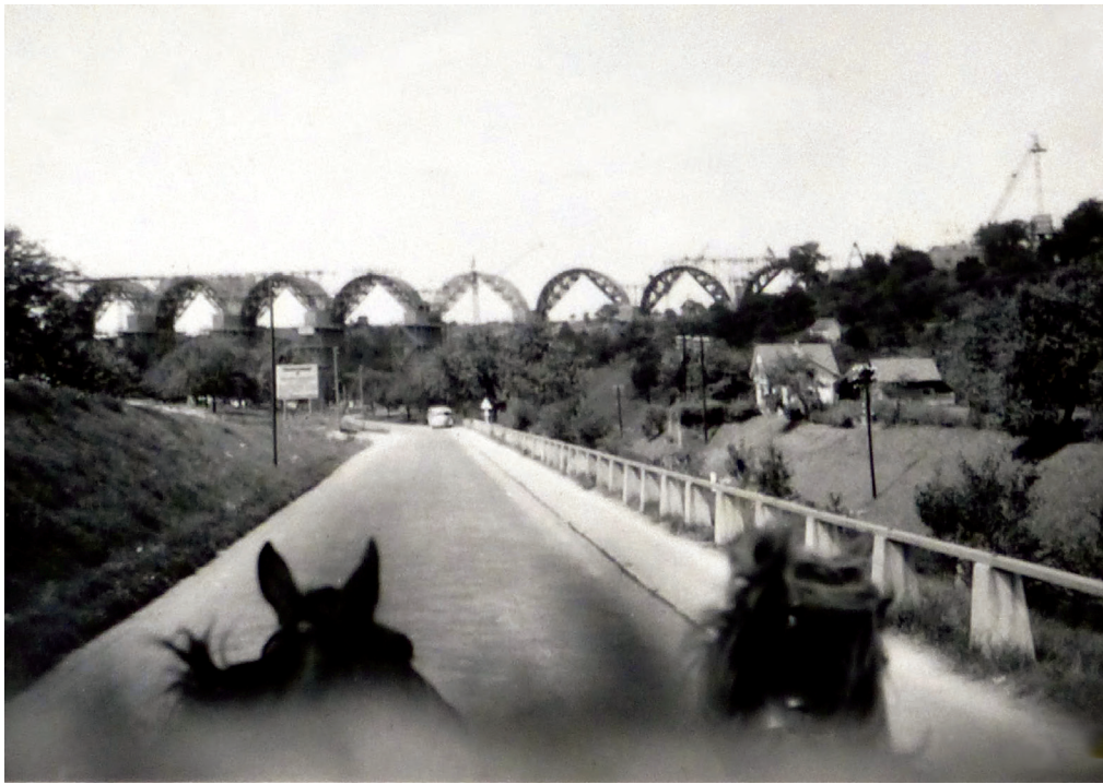
Das sich im Bau befindliche Autobahnviadukt um 1939. Die Autobahnbrücke neben Ispringen ist nicht mehr weg zu denken.
