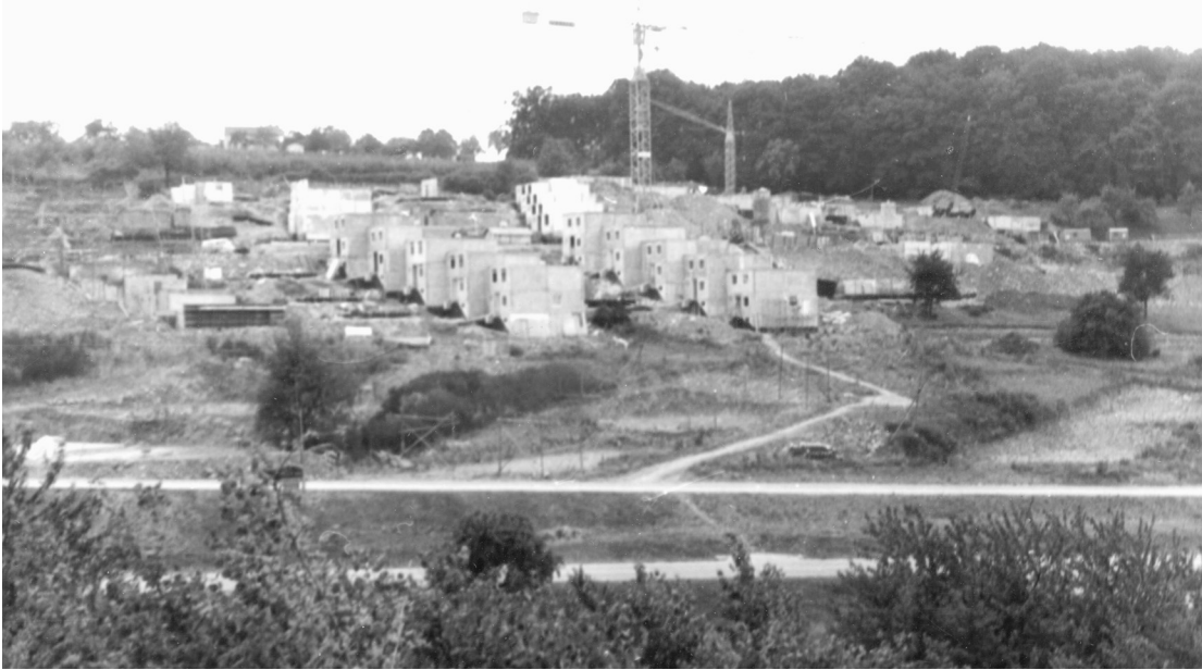
Der Beginn der Baumaßnahmen im Mahler im Juli 1964
