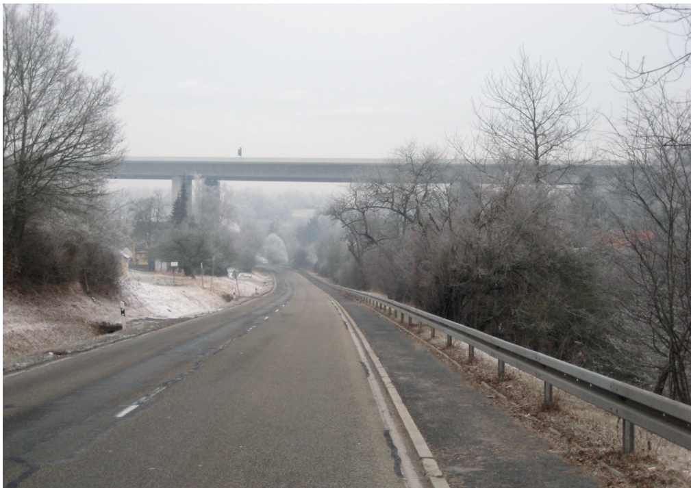
Das dritte Autobahnviadukt, welches im Winter 2007 errichtet wurde.
